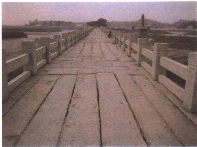
▲ 利用生物固基技术建造的福建泉州洛阳江桥，这座桥今天仍在使用，长1000米，宽5米，建于公元1059年
