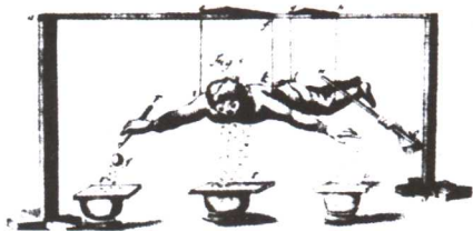
▲ 17世纪欧洲经常表演的一个电学实验。细线悬挂着小男孩，用起电机使他带电，孩子身体和手臂可以吸引轻小的物体
