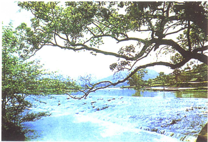
▲灵渠小天平滚水坝，灵渠开凿于公元前214年，位于广西壮族自治区兴安县境内
