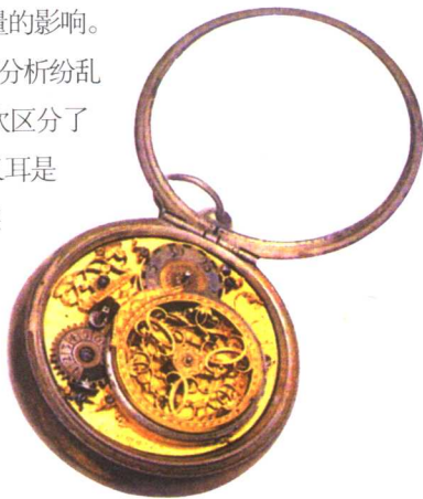
▲采用游丝摆轮的怀表，这件发明迈出了计时仪器小型化的关键一步
